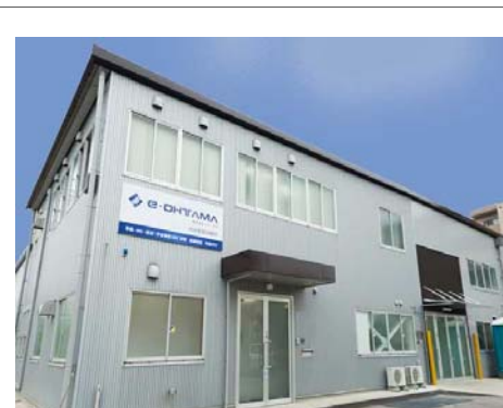
刈谷駅前試験所 外観
