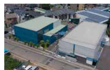
上空から見たA棟(写真左)とB棟(同右)
