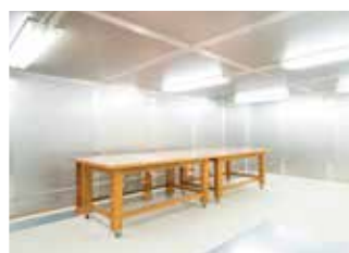
シールドルーム内部
