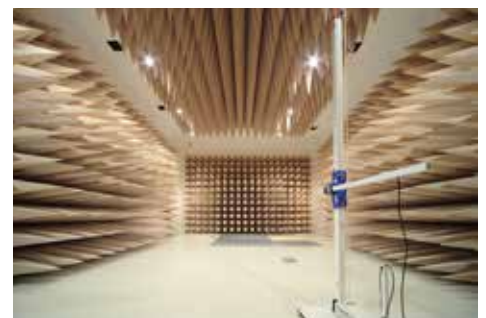
10m法電波暗室内部
