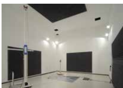
車載用電波暗室内部
