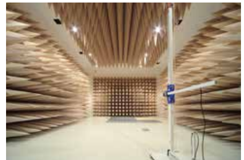
10m法電波暗室内部
