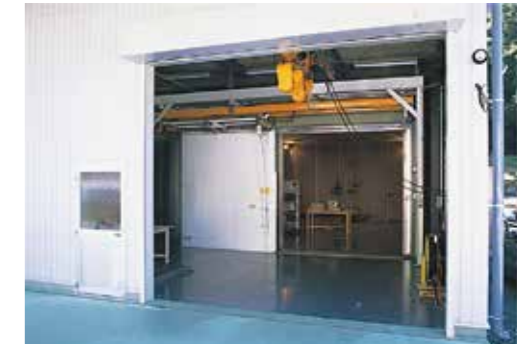
大型電波暗室搬入口
