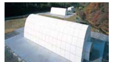
山梨 EMCセンター芦川試験所オープンサイト全景
