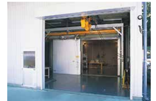
大型電波暗室搬入口
